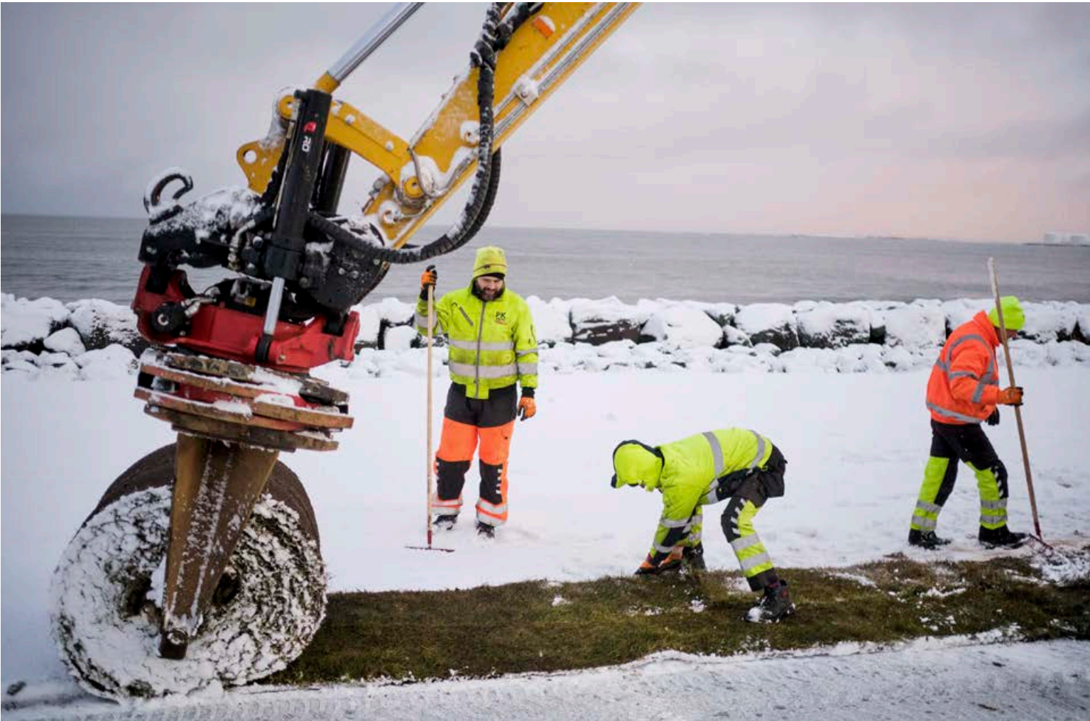
Frost og fönn hindra menn ekki við verk sem að öllu jöfnu teljast til sumarverka. Hér er ekki slegið slöku við í þökulagningu í snjó við nýjan hjóla- stíg á Eðisgranda í Vesturbæ Reykjavíkur. Verkið gekk greiðlega og létu menn kuldann ekki á sig fá við störf. FRÉTTABLAÐID/ANTON BRINK
