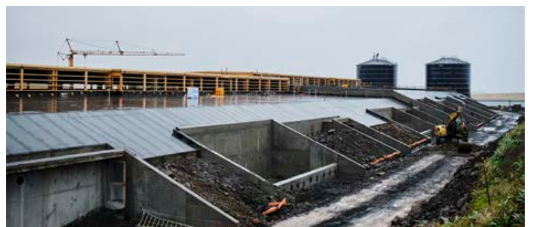
Frá byggingu gas- og jarðgerðarstöðvarinnar. FRÉTTABLAÐIÐ/ANTON BRINK
