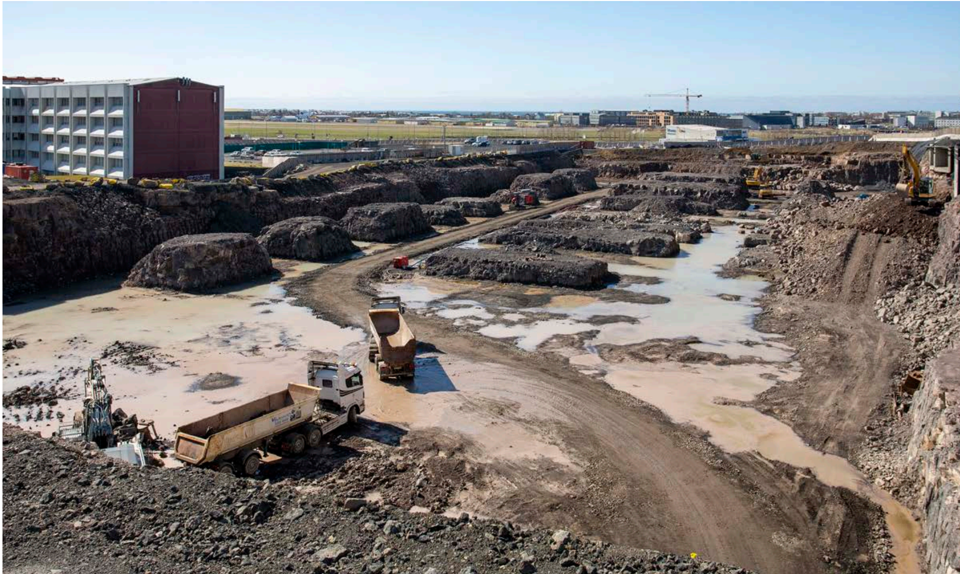
Vinna við byggingu nýs Landspítala er í fullum gangi. Til stendur að ljúka jarðvinnu vegna meðferðarkjarnans í maí en um er að ræða stærstu bygginguna í verkefninu. Samkvæmt áætlunum á vinnu við meðferðarkjarnann að ljúka 2025. Grunnurinn, sem sést á myndinni, er tæplega 19 þúsund fermetrar að stærð og er 18 metrar þar sem hann er dýpstur. FRÉTTABLAÐIÐ/VALLI
