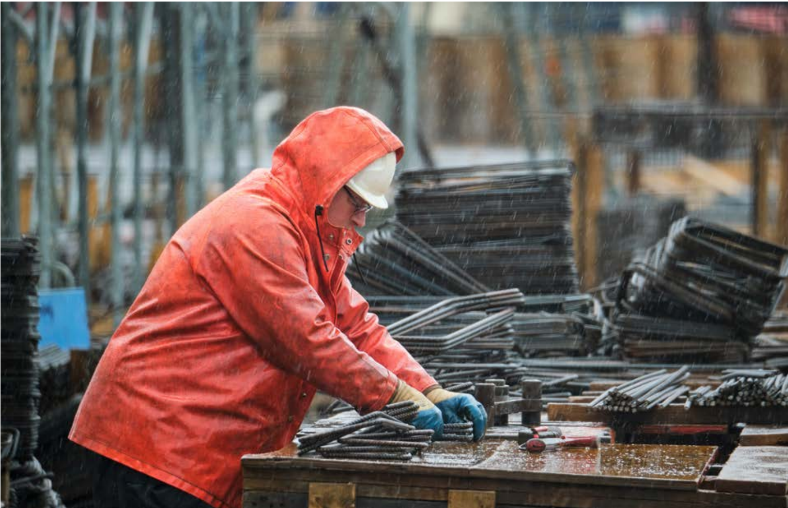
Byggingu nýrra höfuðstöðva Landsbankans við Hörpu miðar vel. Þar var í gær meðal annars unnið að járnabindingum og létu menn ekki úrkomu í höfuðborginni á sig fá. Gert er nú ráð fyrir að kostnaðurinn við bygginguna nemi 11,8 milljörðum króna, en það er tæplega tveimur milljörðum meira en upphaflega var áætlað. Alls verður húsið 16.500 fermetrar að stærð, en bankinn ætlar þó aðeins að nýta það að hluta. FRÉTTABLAÐIÐ/ANTON
