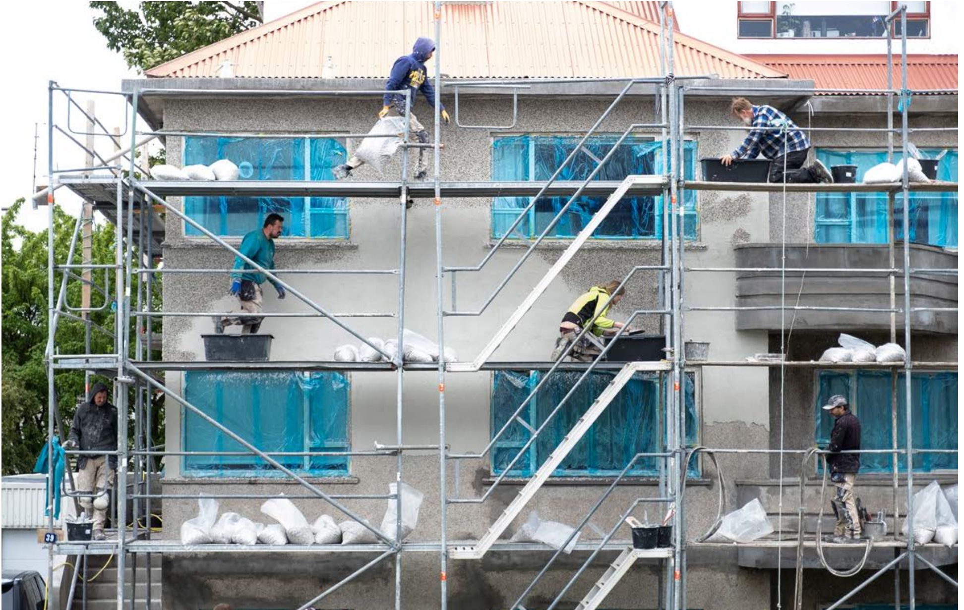
Þessir duglegu menn unnu hörðum höndum við steiningu þessa fallega húss við Mávahlíð í Reykjavík í gær. Steining er gamalreynnd aðferð við frágang útveggja sem fundin var upp á Íslandi upp úr 1930. Líklega má finna yfir 3.000 hús hér á landi sem steinuð eru með hrafntinnu-, kvars- eða skeljamulningi og þykja þau í augum margra mikil þrýði. FRÉTTABLAÐIÐ/ERNIR
