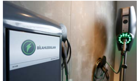
EVBox hleðslutækini bjóða upp á allt að 350kw hleðslu.
