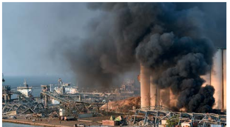
Gríðarleg eyðilegging varð á svæðinu þar sem sprengingin varð. MYND/EPA
