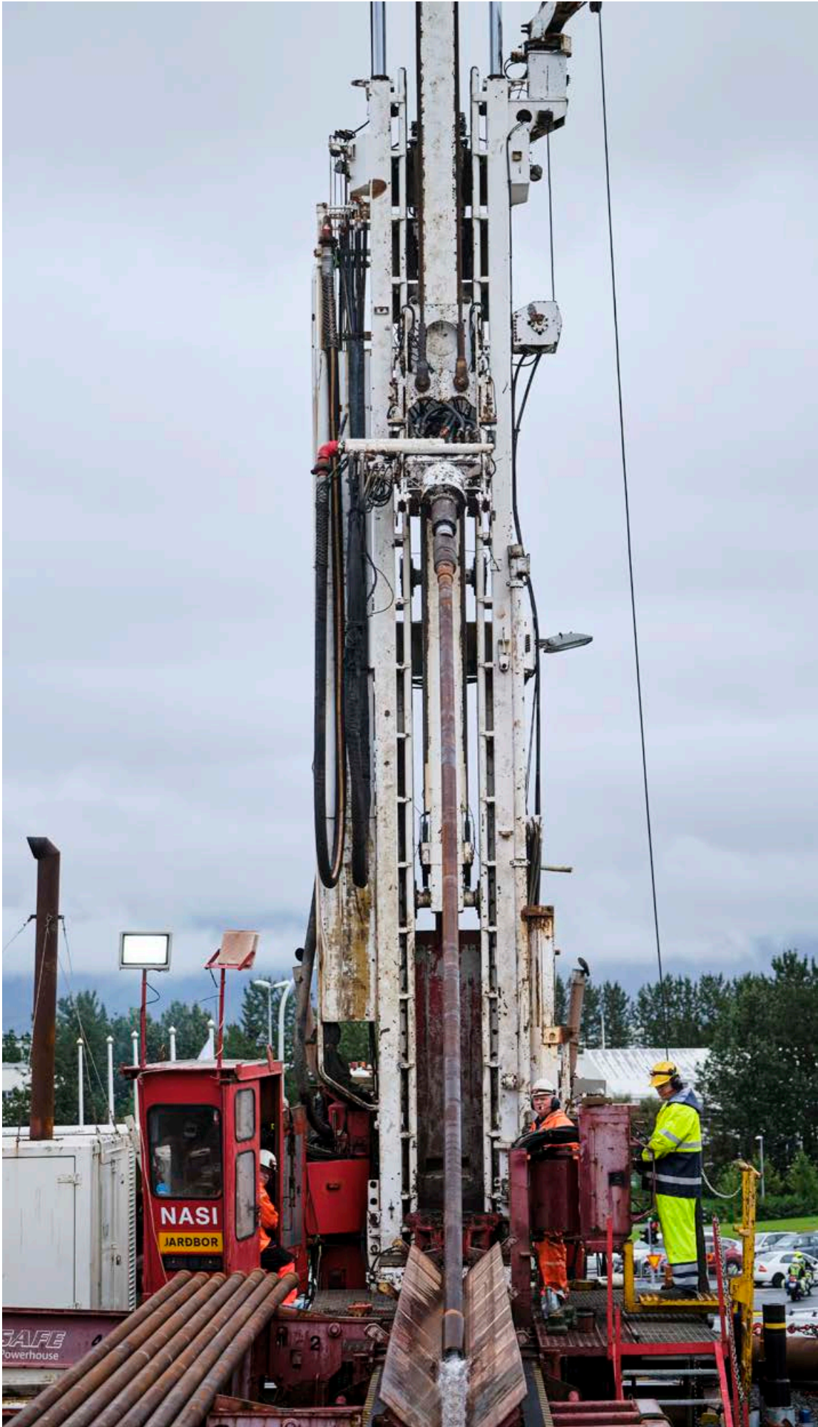
Jarðborinn Nasi er kominn hnarreistur á sinn stað við Bolholt. Veitur eru að vikka tæplega sextuga heitavatns-holu sem þörf var á að endurbæta, fjarlægja þrengingar og fódra að nýju. Kunnáttumenn segja að hún verði betri en ný eftir umbæturnar og vonast er til að hún verði endurvirkjuð fyrir næsta vetur. FRÉTTABLAÐIÐ/ANTON BRINK
