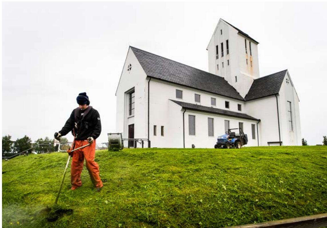
Enginn hefur sett svo mikið sem þakpapparámu yfir versta lekann, segir Skálholtsbiskup. FRÉTTABLAÐIÐ/SIGTRYGGUR
