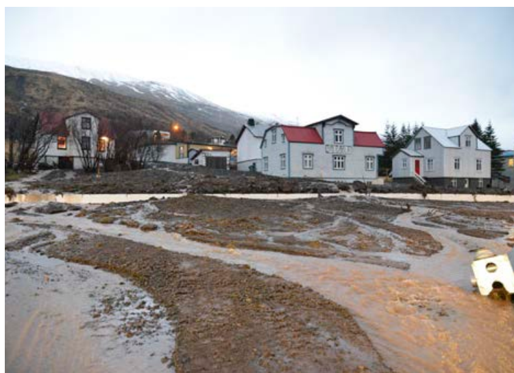
Tjónið er mikið og er búið að flæða í marga kjallara. MYND/ÓMAR BOGASON
