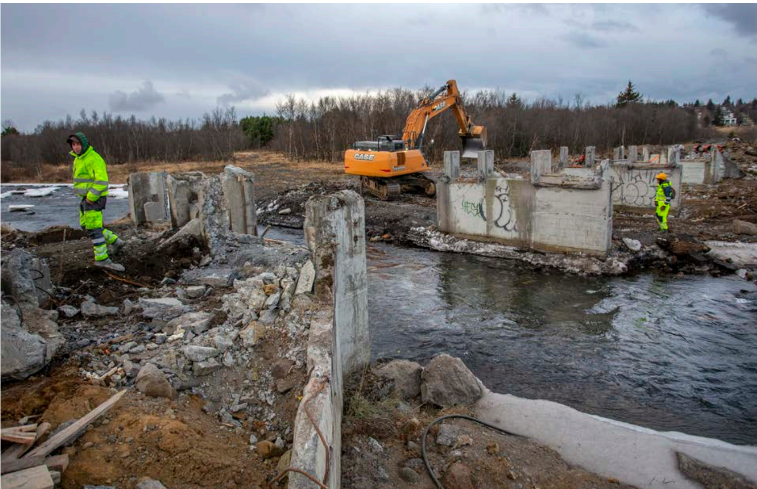
Hitaveitustokkurinn yfir Elliðaárdal neðanverðan er nú óðum að hverfa eftir að hafa þjónað Reykvikingum frá því um 1940. Veitur hafa endurnýjað aðveituaðar sínar og þar sem lagnirnar liggja um dalinn hafa þær verið grafnar í jörðu og undir báðar kvíslar Elliðaáanna. Um er að ræða fráveitulagnir, kaldavatnslagnir, hitaveitulagnir og raflagnir Veitna ásamt fjarskiptalögnum Gagnaveitu Reykjavíkur og Mílu. FRÉTTABLAÐIÐ/VALLI
