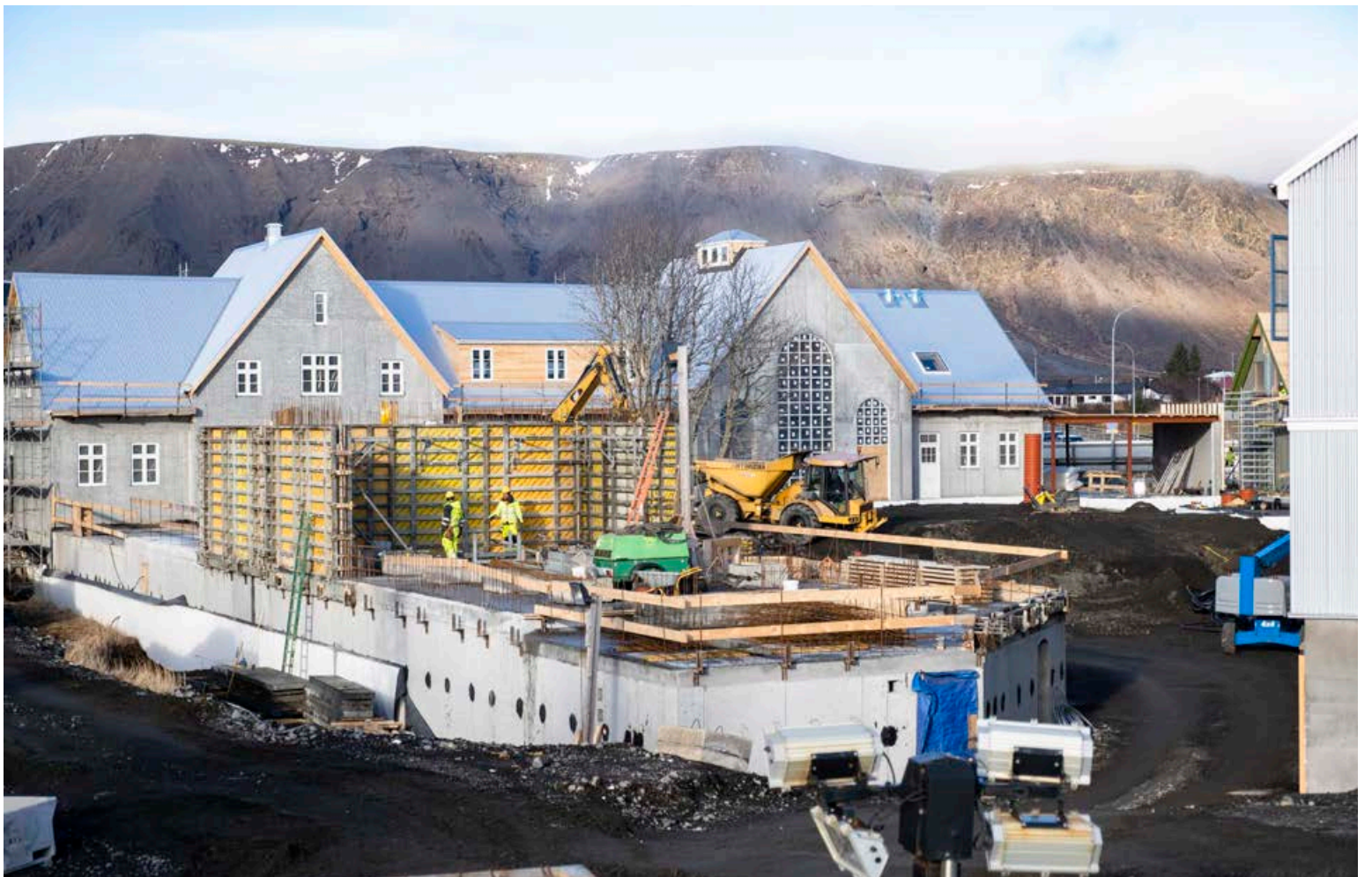
„Það rokengur og búið að gera síðan haustið 2019. Staðarhaldari vonast til að fyrsta áfanga verði lokið í síðasta lagi 17. júní,“ segir Gísli H. Halldórsson, bæjarstjóri Árborgar, um framkvæmdir við miðbæ Selfoss. Áætlað er að framkvæmdum ljúki á næsta ári eða árið 2023. FRÉTTABLAÐIÐ/ERNIR
