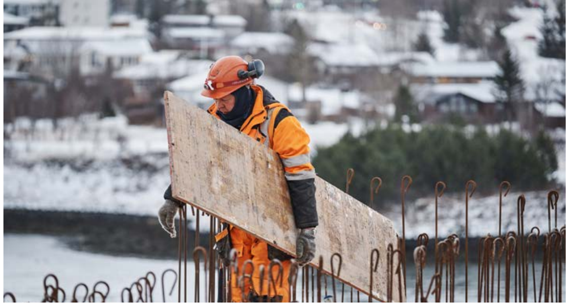
Verktakafyrirtækið ÞG Verk er þessa stundina að byggja íbúðir í Vogabyggð í Reykjavík. FRÉTTABLAÐIÐ/SIGTRYGGUR ARI
