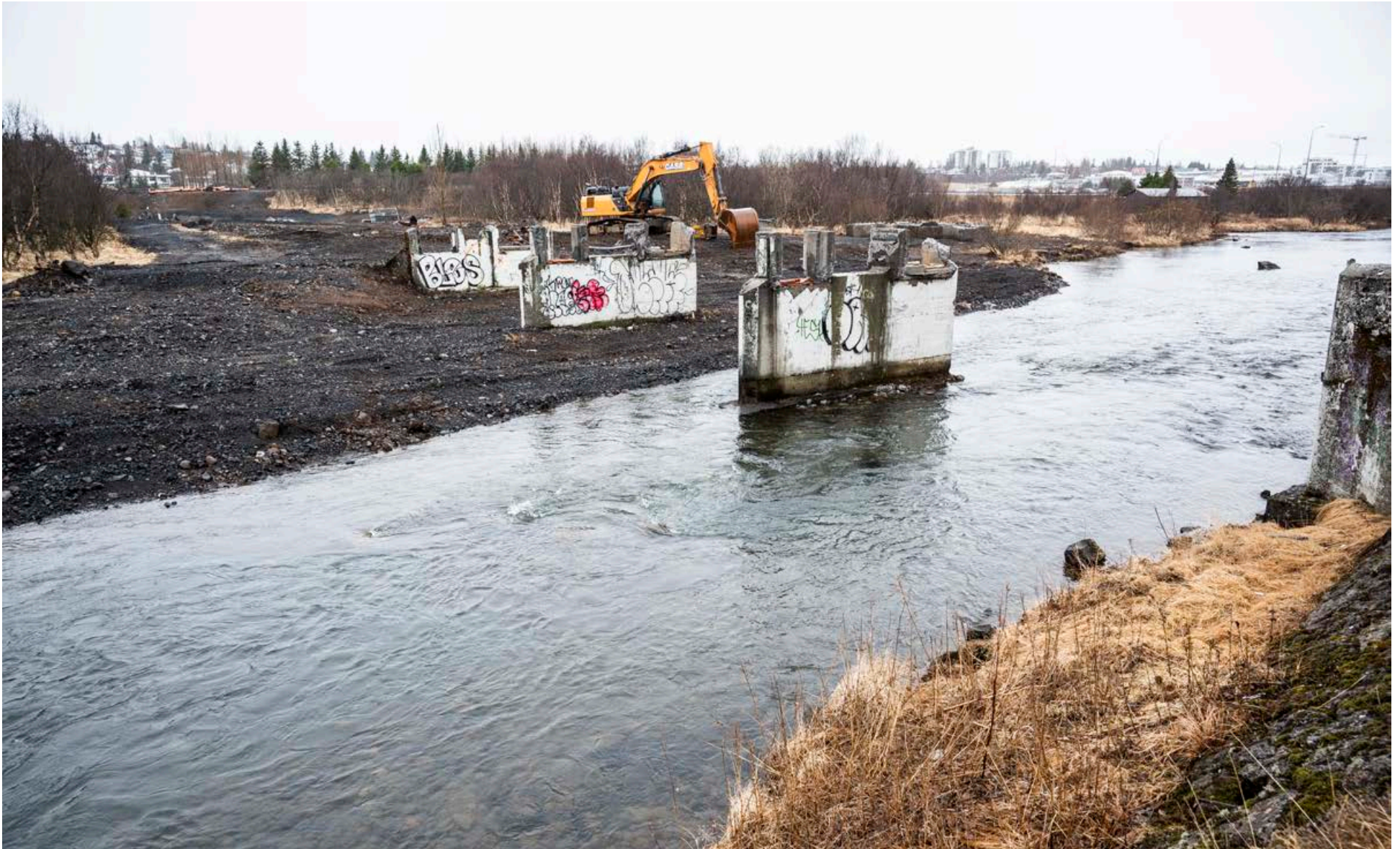
Fáeinir stöplar undan hitaveitustokki yfir neðri hluta Elliðaárdals standa nú eftir. Veitur hafa fjarlægð lagnastokkinn en stöplana ætlar Reykjavíkurborg að nýta undir nýja göngubrú yfir árnar, segir Breki Logason, upplýsingafulltrúi hjá Orkuveitu Reykjavíkur. Allri lagnavinnu er lokið en áætlað er að frágangi verði lokið næsta vor, segir Breki. FRÉTTABLAÐIÐ/SIGTRYGGUR ARI
