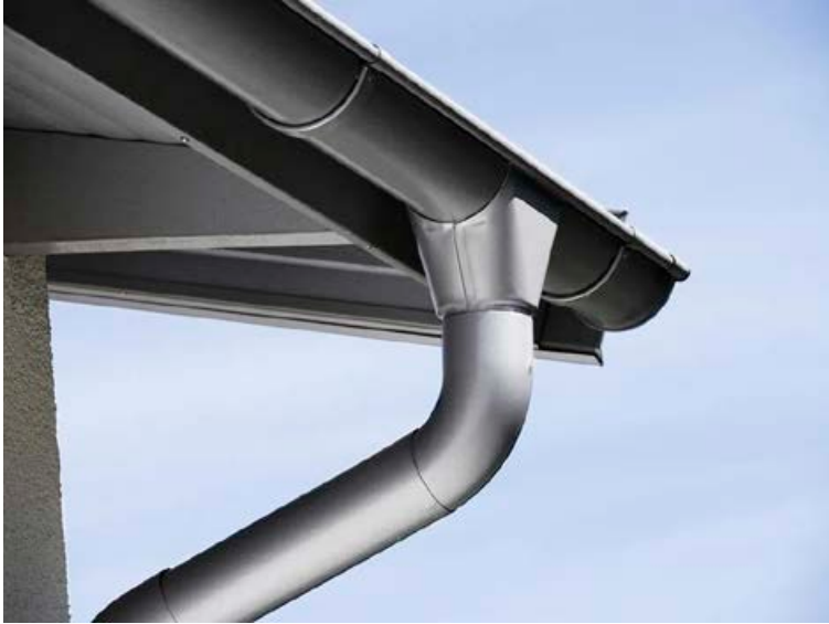
Þakrennurnar koma í ákveðnum lengdum og eru styttrar á staðnum.
