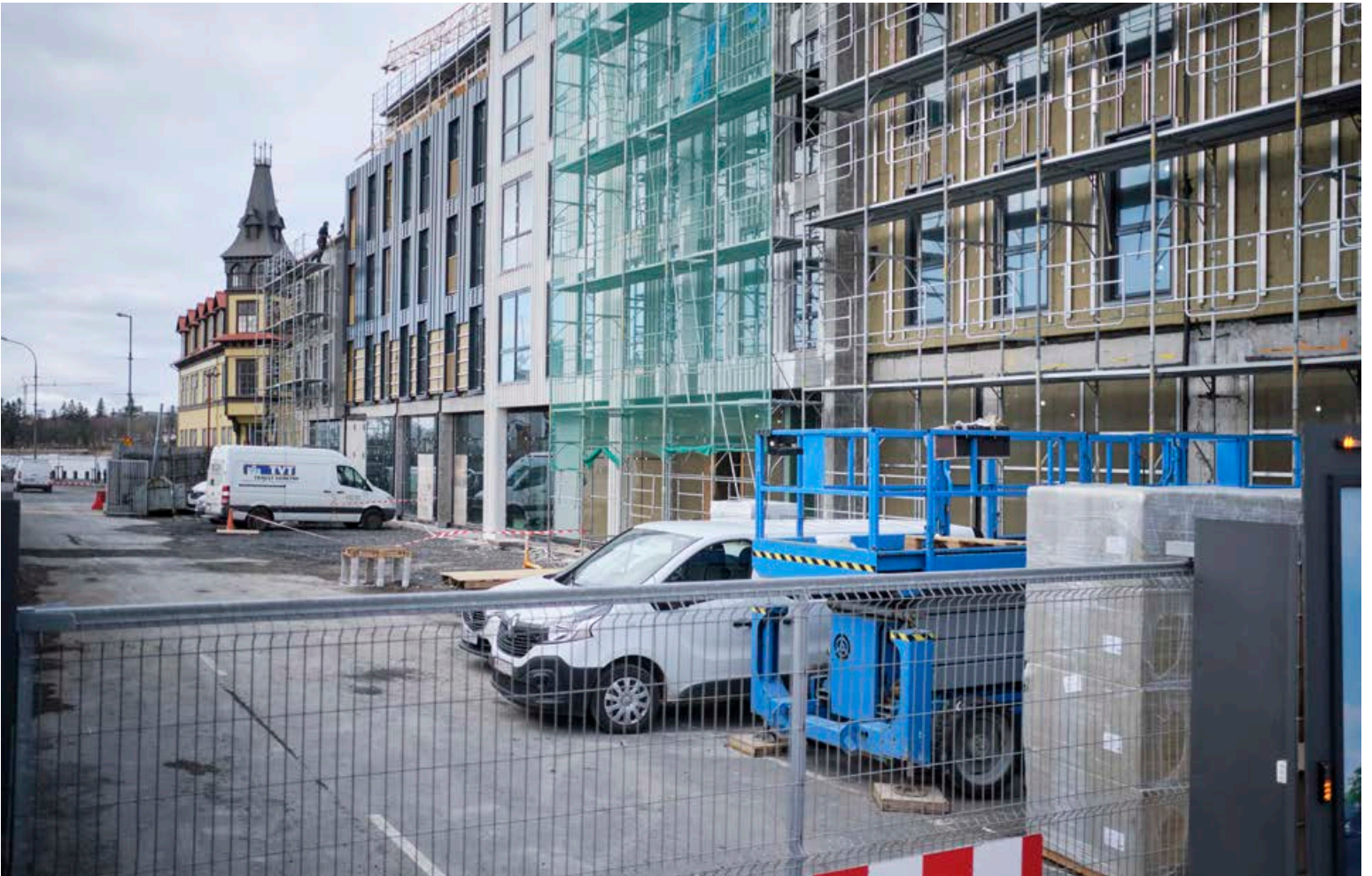
Lækjargatan heldur áfram að vera hálflokuð vegna framkvæmda við hótélbyggingu. Þar leggja nú iðnaðarmenn í bestu stæði miðbæjarins og ólíkt öðrum bílastæðum í miðborginni eru þessi ókeypis. Verktakinn hefur borgað 150 þúsund fyrir afnotaleyfi, til að loka Lækjargötu. Leyfið vegna framkvæmdanna gildir til 15. maí. Að sögn borgaryfirvalda er lagt kapp á að borgarlandinu verði skilað fyrir sumarið. FRÉTTABLAÐIÐ/ANTON BRINK
