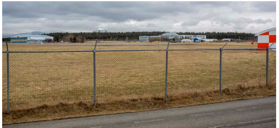
Skýli Landhelgisgæslunnar uppfyllir ekki kröfur. Rétt er um að færa aðstöðuna til hægri. FRÉTTABLAÐIÐ/VALLI
