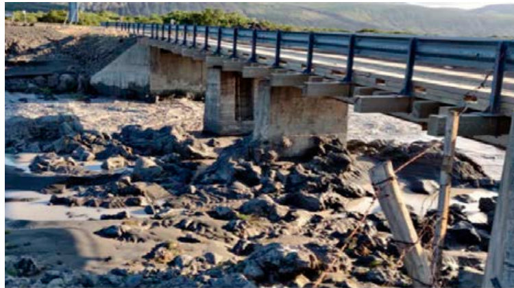
Mikil ummerki sáust í farvegi Hvítár við Kaldadalsveg.
