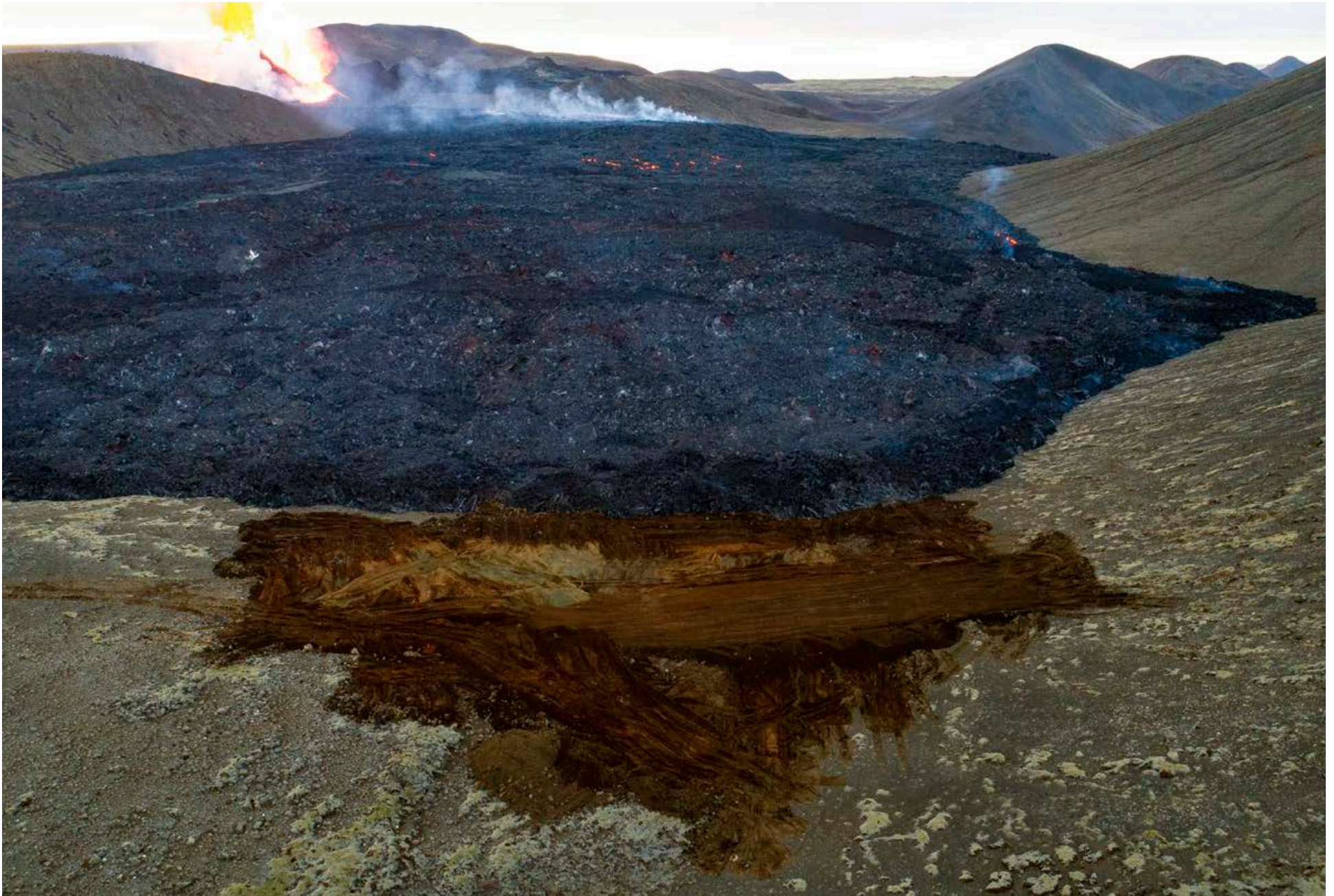
Varnargarðar eru nú í smíðum í Geldingadölum. Varnargarðarnir tveir eiga að hraun renni niður í Nátthaga en þaðan ætti hraunið nokkuð greiða leið niður á Suðurstrandarveg.
