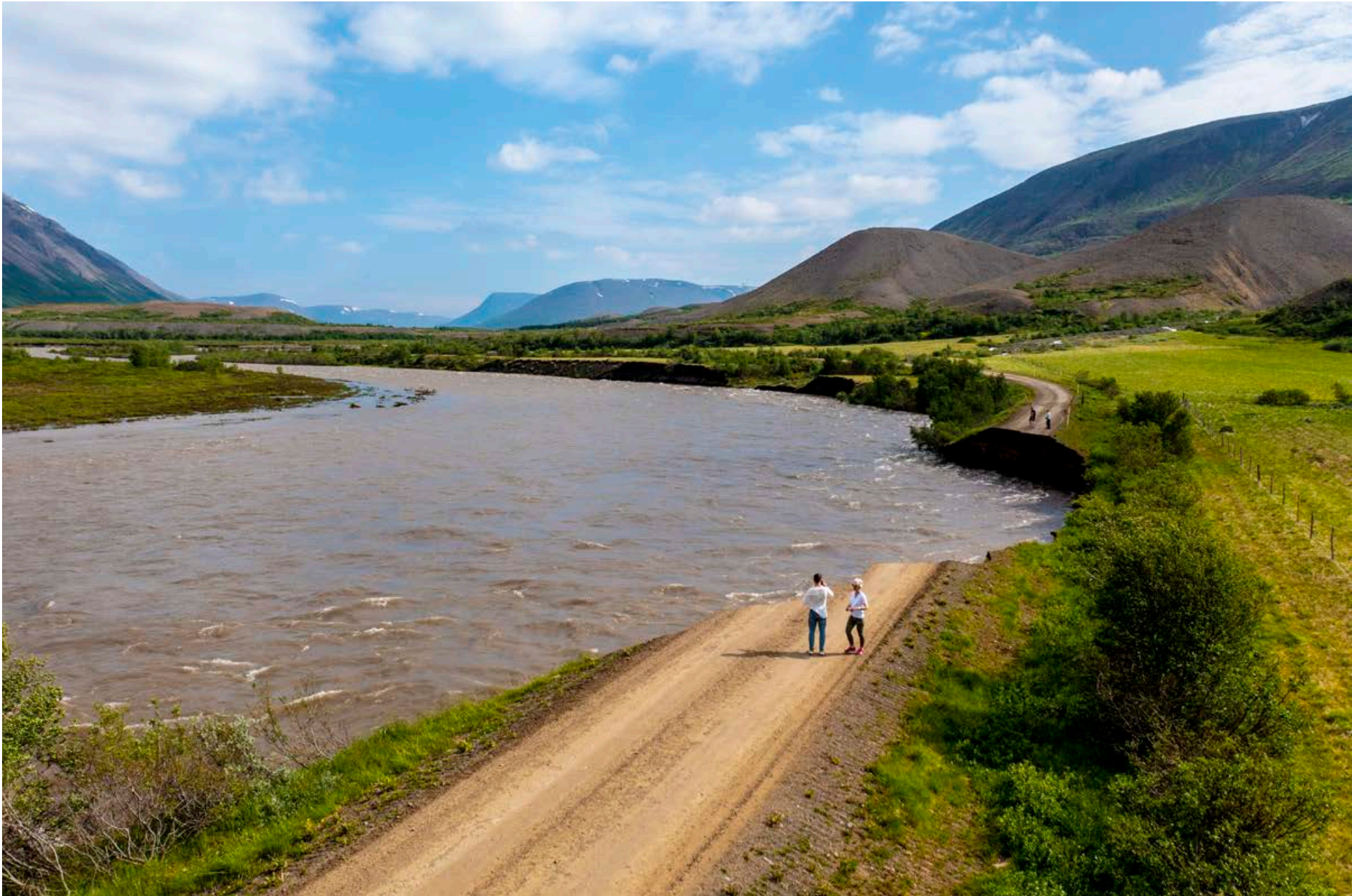
Fólk virðir fyrir sér veg sem rofnaði eftir að Fnjóská ruddist niður farveg sinn. Vatnavextir á Norðurlandi eystra hafa verið miklir undanfarna daga og víða orðið tjón. Hefur ríkislögreglustjóri í samráði við Lögreglustjóran á Norðurlandi eystra lýst yfir hættustigi. Vegagerðin segir að flóð sem þessi gerist líklega aðeins á 50 til 100 ára fresti. Fjallað er um málið á frettabladid.is . FRÉTTABLAÐIÐ/AUÐUNN
