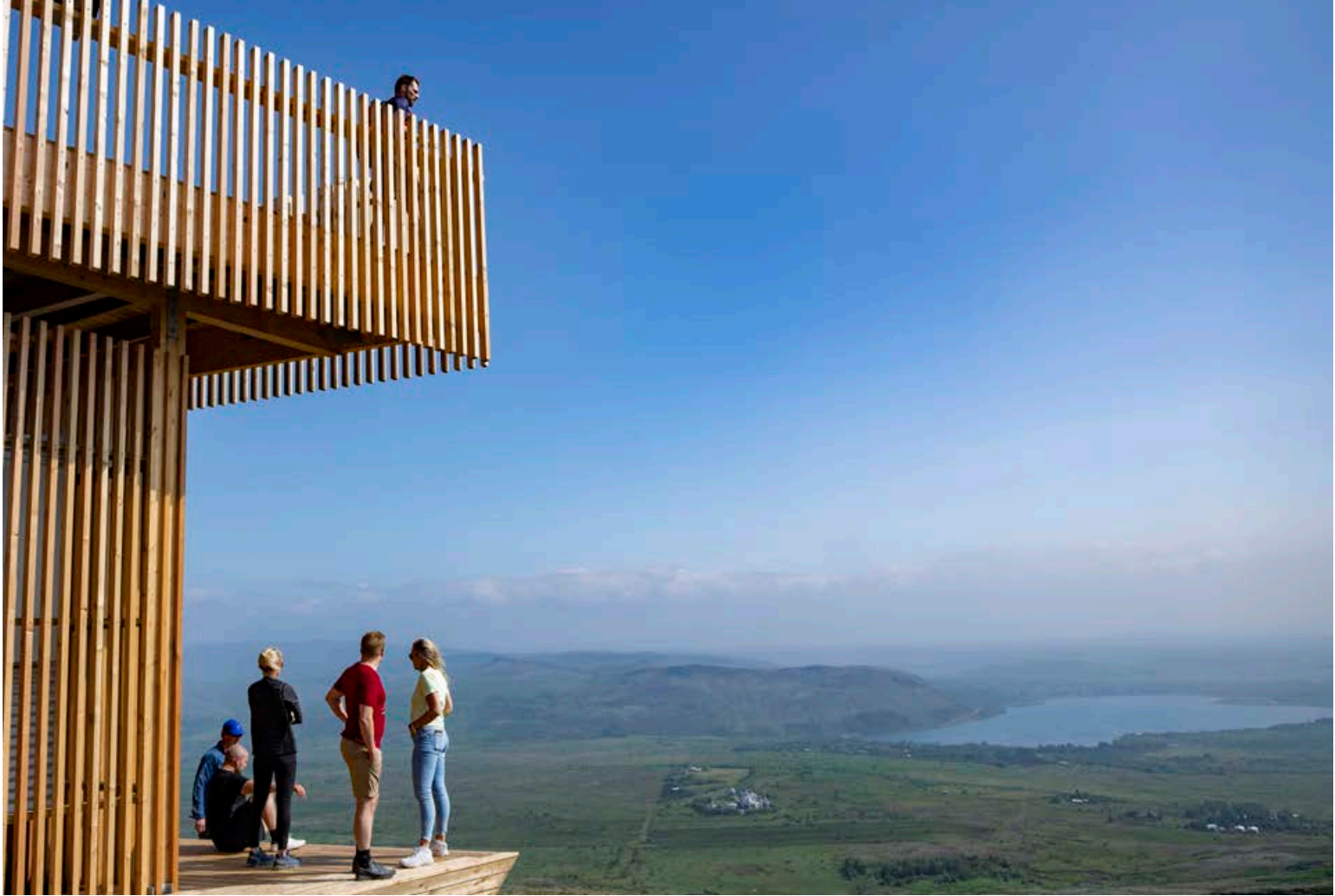
Fjarskiptamastur Neyðarlínunnar, RÚV og Vodafone sem fyrirtækin hafa reist á toppi Úlfarsfells, hefur fengið félagsskap af nýju mannvirki, útsýnispalli sem opnaður var formlega í gær. „Útsýnispallurinn er byggður úr náttúrulegu byggingarefni til að lágmarka sjónræn áhrif mannvirkisins og til þess að það falli sem best að umhverfinu“, segir í tilkynningu. Á pallinum séu fjögur fræðsluskilti með örnefnum og bekkur fyrir göngufólk.
