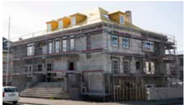
Það eru 75 ár síðan húsið var reist en það hefur staðið autt undanfarnin ár.
