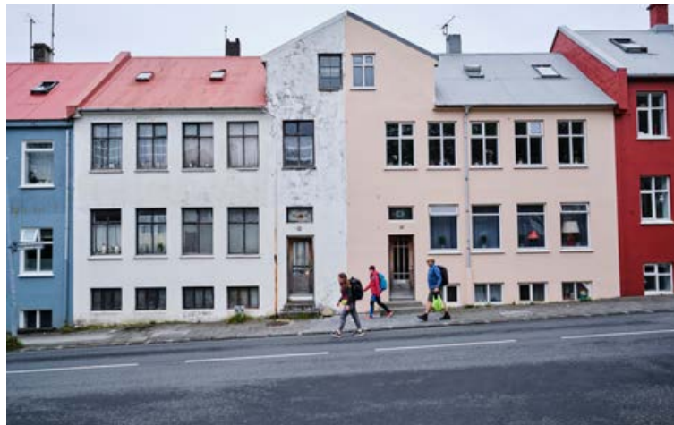
Njarðargata 35 sker sig töluvert úr húsaröðinni við þessa fallegu götu. Húsið hefur staðið autt síðan 1991. FRÉTTABLAÐIÐ/ANTON BRINK
