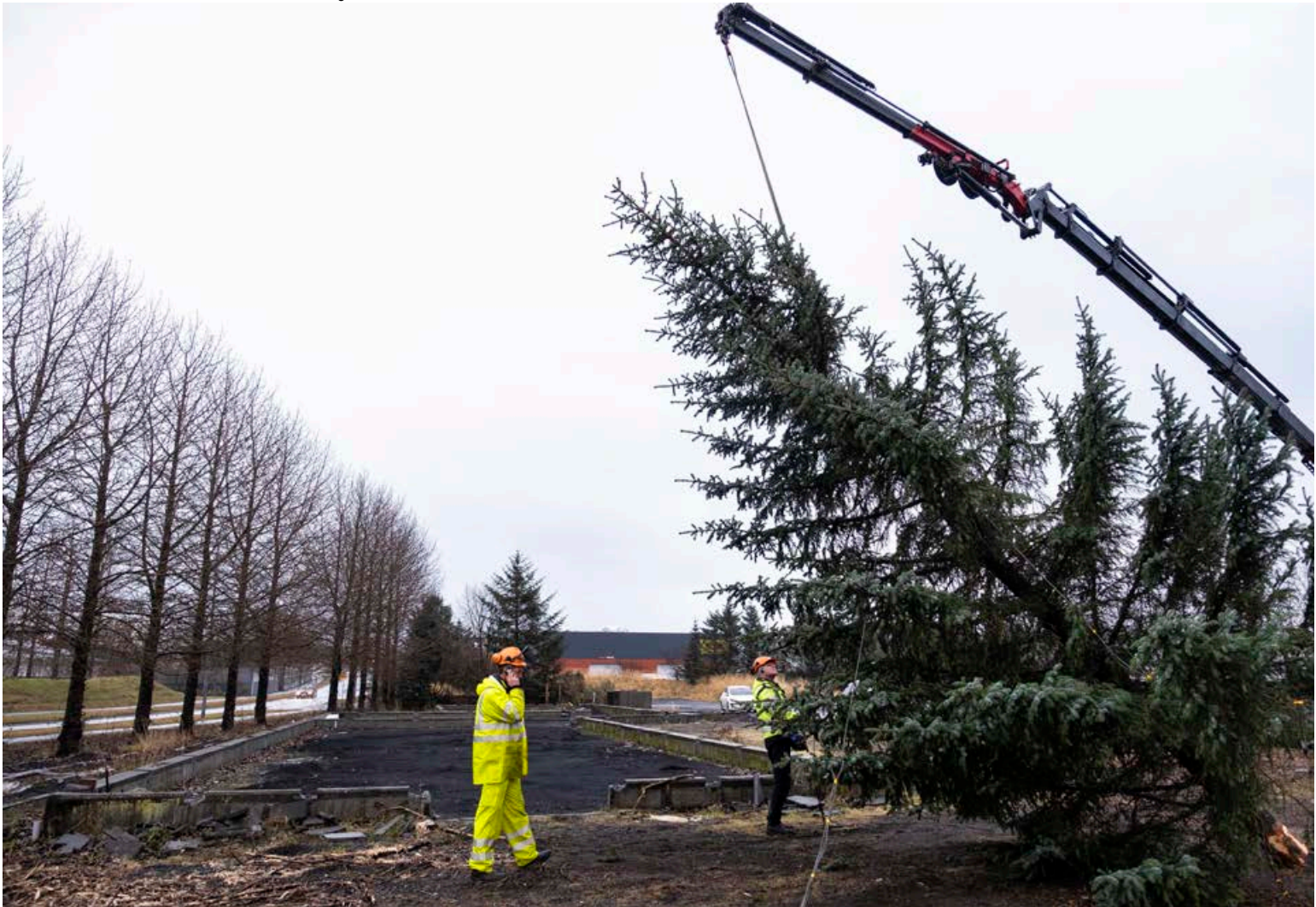
Verið er að höggva niður síðustu trén á lóð þar sem Gróðrarstöðin Storð stóð við Dalveg í Kópavogi. Til stendur að verslunar- og skrifstofuhúsnæði rísi á svæðinu en gróðrarstöðin er nú flutt eftir 25 ár í Laugarás í Bláskógabyggð. Tvö trén verða dubbuð upp sem jólatré í Kópavogi yfir hátíðirnar. FRÉTTABLAÐIÐ/ERNIR
