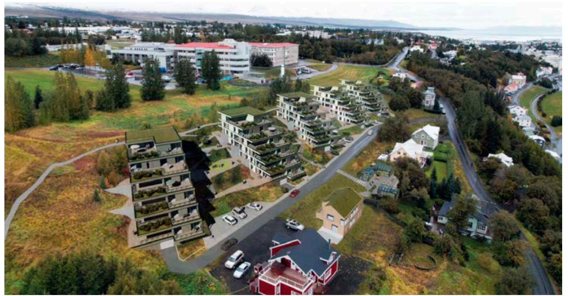
Mikil átök hafa ítrekað blossað upp um fyrirhugaðar framkvæmdir til þéttingar byggðar á Akureyri. Nú er deilt um skriðuhættu og jarðvegsburðarþol, ef þessar byggingar við Tónatröð verða að veruleika. MYND/ADSEND
