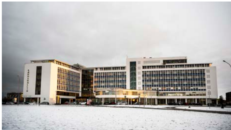
Bændahöllin, eða Hótel Saga eins og byggingin er kölluð í daglegu tali, er eitt helsta kennileiti Vesturbæjarins.
