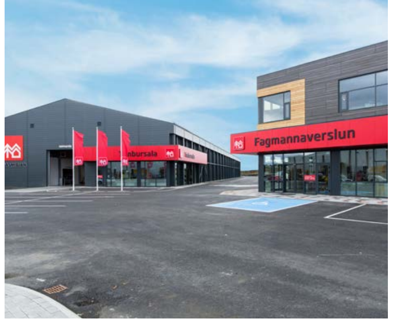
Verslunin að Kjarlövgi er útbúin fjórum hleðslustöðvum fyrir rafbíla.
