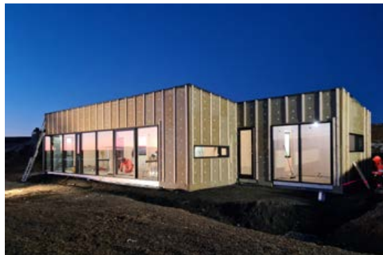
Heilsárshús í byggingu (sérpöntun).
