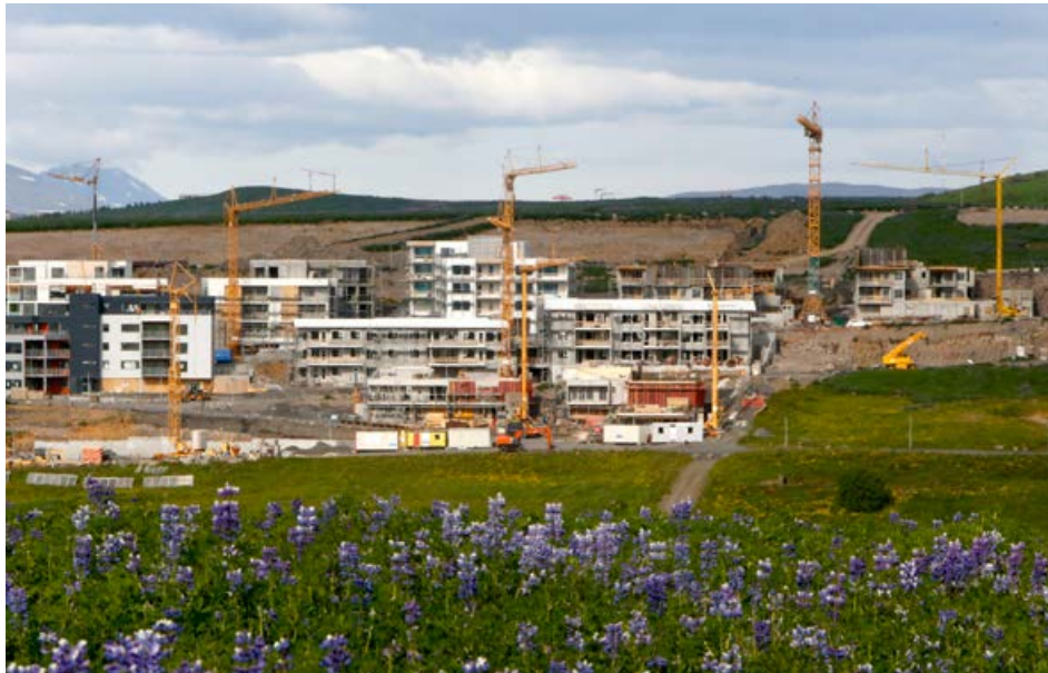
Uppbygging leikskóla hefur ekki fylgt uppbyggingu íbúðarhúsnæðis í Urriðaholti.
