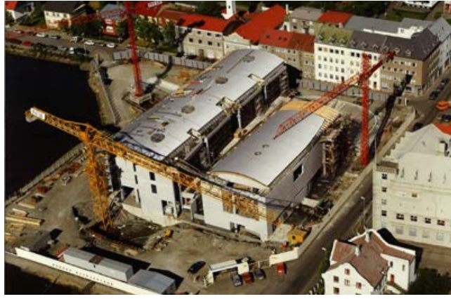
Frá byggingu Ráðhússins. Margir voru ósáttir við staðsetningu byggingarinnar.
