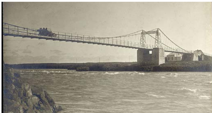
Bygging Ölfusárbrúar árið 1891 markaði tímamót í íslenski verkfræðisögu. Upprunalega brúin féll árið 1944 og ári síðar var nýja brúin sem stendur enn tekin í notkun.
