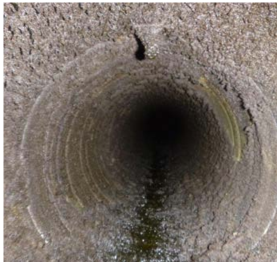
Hér sést hvernig mikil óhreinindi hafa tekið sér bólfestu í loftstokki sem var tengdur eldhúsi. Ef þetta er ekki þrifið getur þetta verið heilsuspillandi
