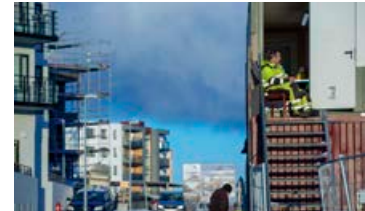
7.260 íbúðir voru í byggingu í mars.
