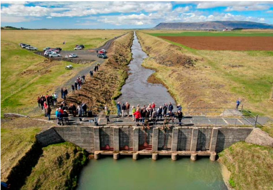
Inntaksmannvirki Flóaáveitu skammt fyrir neðan Hvítá þar sem fjölmenni var um helgina.
