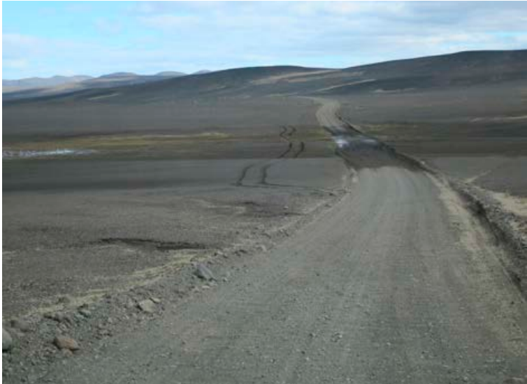
Umhverfisspjöllin í upphafi vikunnar voru unnin á þremur stöðum í Vatna- jökulsþjóðgarði, á Kverkfjallavegi innan við Möðrudal, á gatnamótunum við Herðubreiðartöglin og við brúna við Upptypinga.
