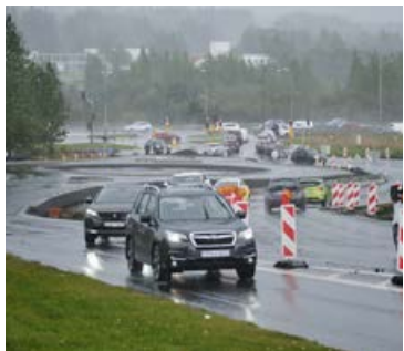
Framkvæmdir standa yfir í þrjá daga.
