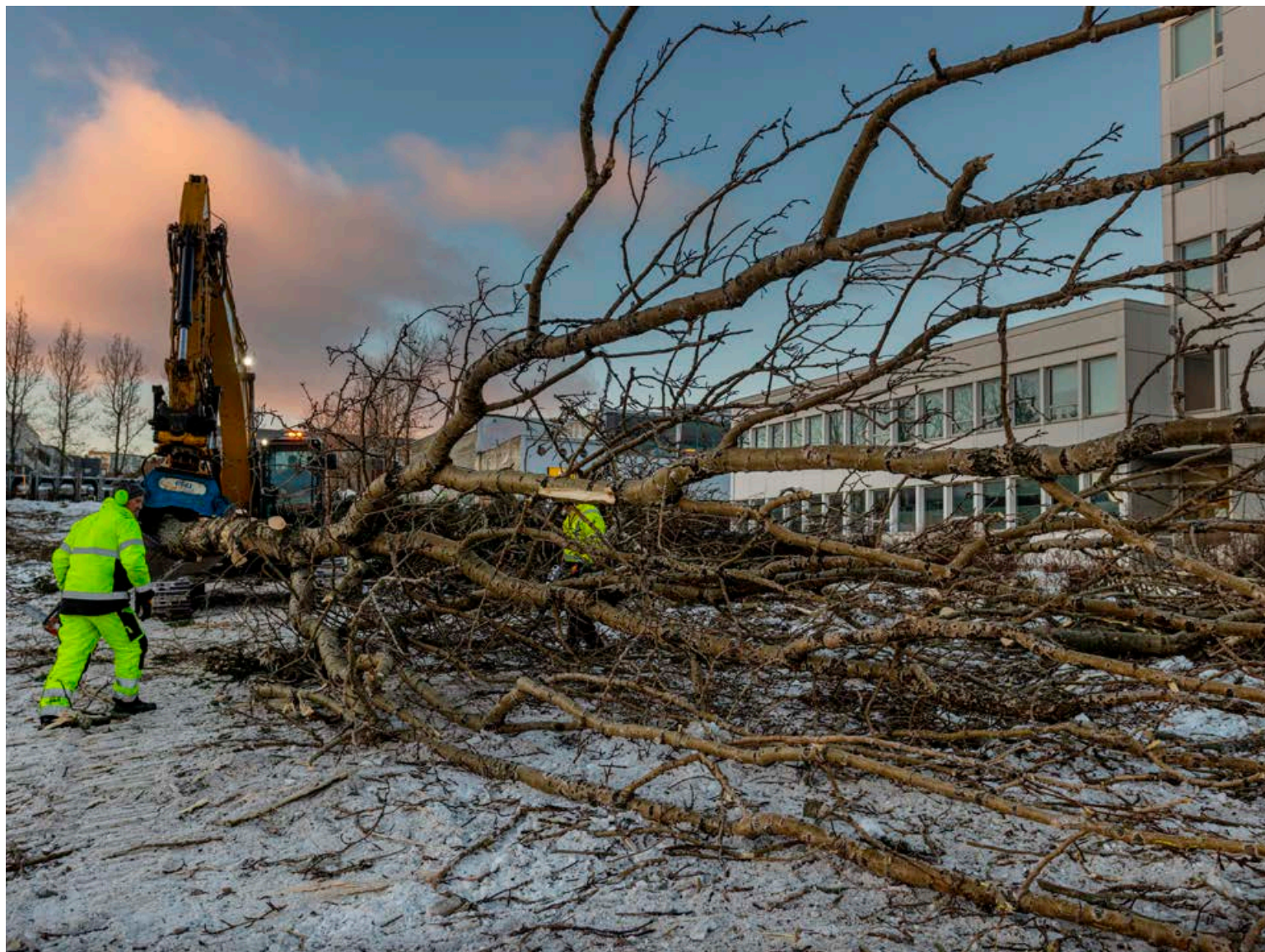
Tré fellt við Suðurlandsbraut á hinni svokölluðu Orkuhússlóð. Allt að 500 íbúðir verða byggðar á lóðinni sem nær einnig yfir á Ármúlann.
