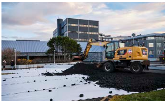
Framkvæmdir standa nú yfir í Seðlabankanum.
