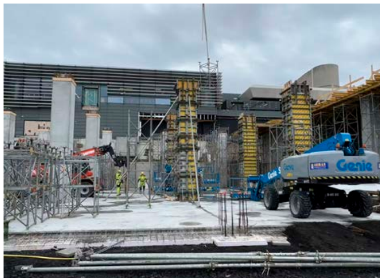
Framkvæmdir austan megin við flugstöðina.
