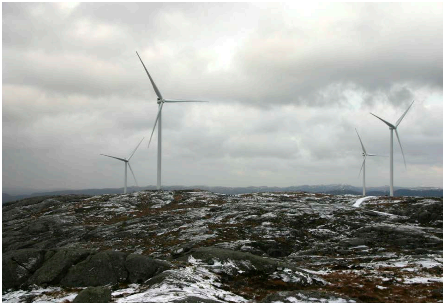
Þessa mynd tók Ketill í Tellenes-vindmyllugarðinum í skammdeginu í desember síðastliðnum.
