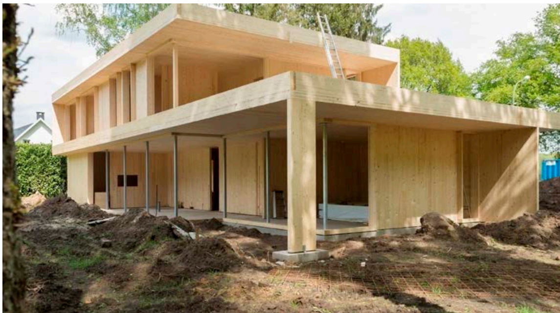
Fyrirtækið gerði nýlega samning við þýskt fyrirtæki um innflutingu á krosslímdu límtré (CLT). Byrjað er að bjóða það í íbúðarhúsum og milligólf.
