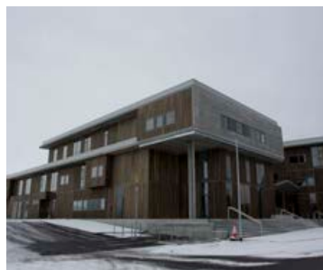
Framhaldsskólinn í Mosfellsbæ er dæmi um vel heppnaða byggingu.
