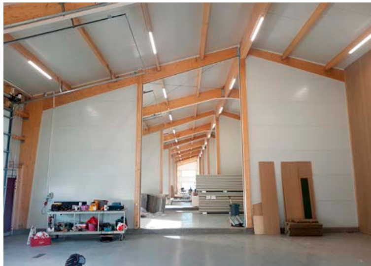
Hér sést hvernig húsinu er skipt upp með bilum frá Límtré Vírneti en þarna á eftir að loka veggjunum.
