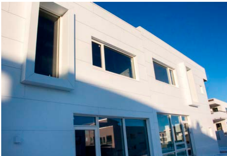
Hægt er fá álklæðningarnar tilsníðnar svo þær séu tilbúnar til uppsetningar. Hér má sjá fallett hús með sléttplötuklæðningu.
