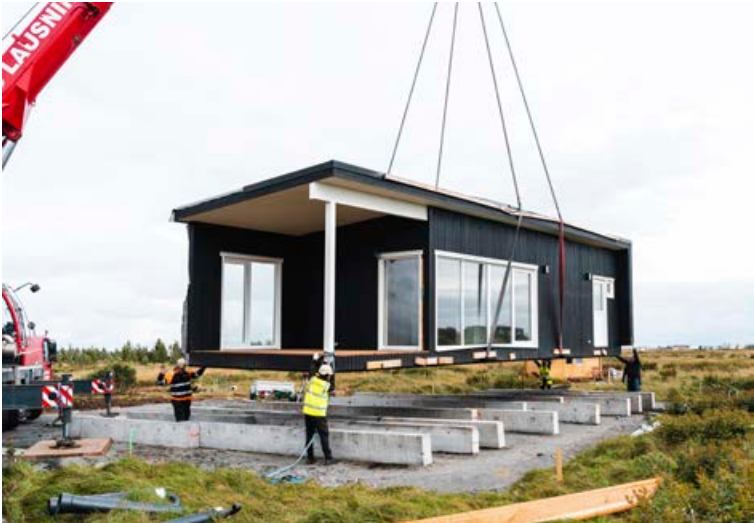
Öflugur krani sér um að hifa einingahúsin á grunninn. Allt ferlið tekur ótrúlega skamman tíma. MYND/ADSEND
