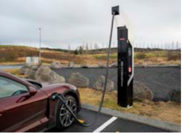
Stöðin er svo öflug að hún þarf vatnaskælingu og þá einnig í hleðslu snúrunni sem tengd er við bílinn.
