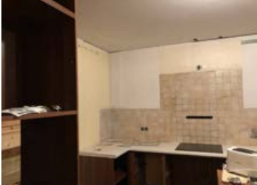
Fyrsta verk var að rífa niður alla innréttinguna og léttu á eldhúsinu.
