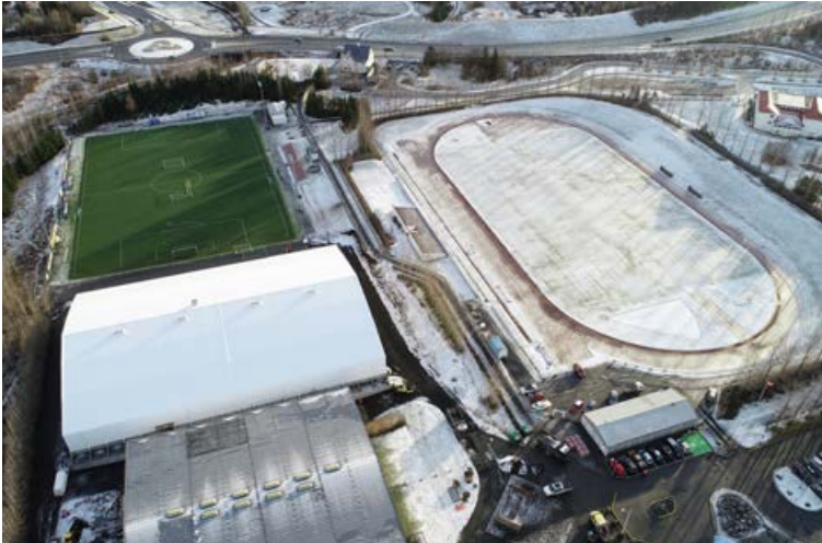
Íþróttasvæði að Varmá, Mosfellsbæ. Verkís var aðalráðgjafi árið 2019.
