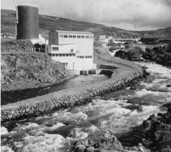
Laxárvirkjun rekur uppruna sinn til ársins 1939.
