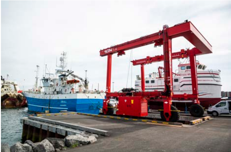
Skip geta nú tengst rafmagni í Hafnarfjarðarhöfn og fengið rafmagn sem er í samræmi við rafmagnskerfi skipsins, en aflið er allt að 1,2 MW.
